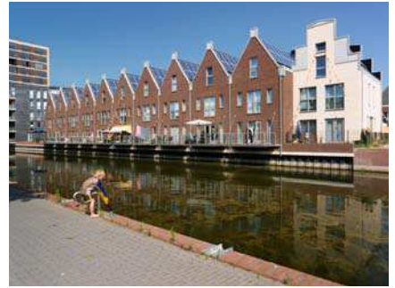
Nieuwbouw en Herstructurering
