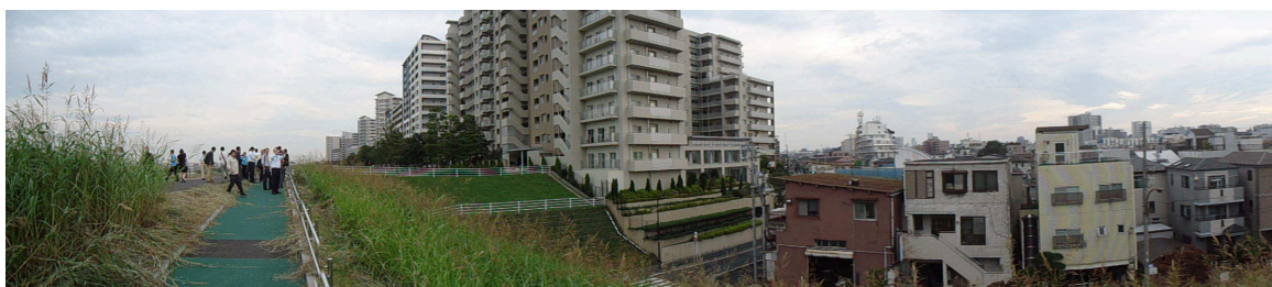
Figuur 3.3 Superlevee Arakawa river. De superdijk gefotografeerd vanaf de traditionele dijk.
