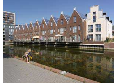
Nieuwbouw en Herstructurering
