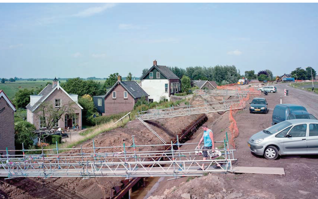
Dijkversterking aan de Lek
