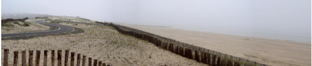
Figuur 9 Foto van een zandige kustversterking bij de zeedijk van Nieuwvliet, waardoor een nieuw duin en strand is ontstaan met recreatieve meerwaarde (Bron: Maïke Warmerdam).
