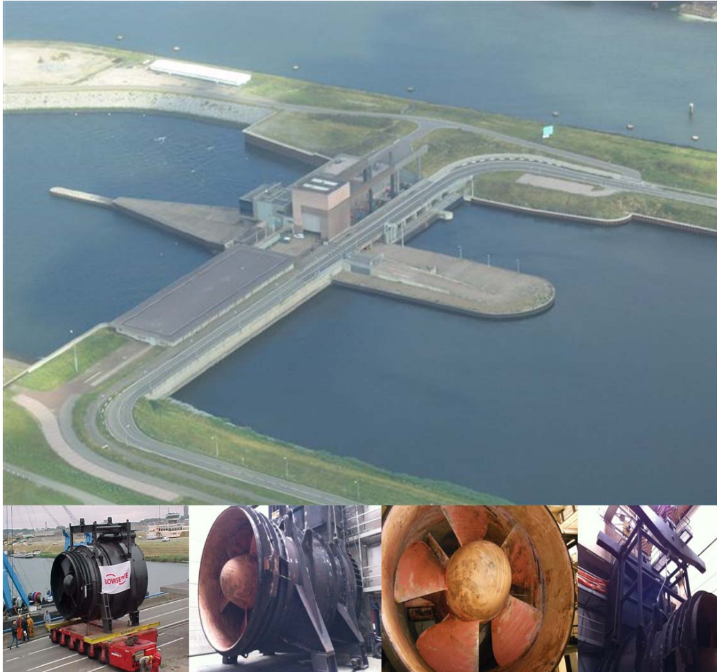
Figuur 1 Het Gemaal- en Spuicomplex IJmuiden en de pompen van het Gemaal.
