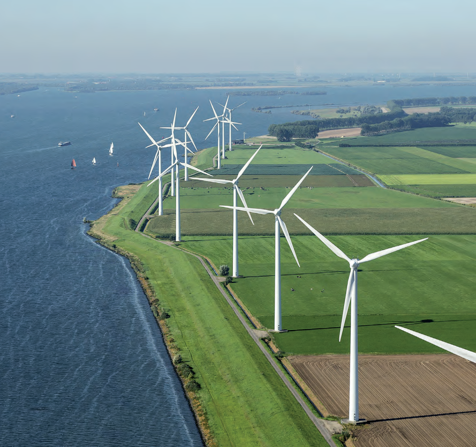
Windturbines aan de rand van het Volkerrak
