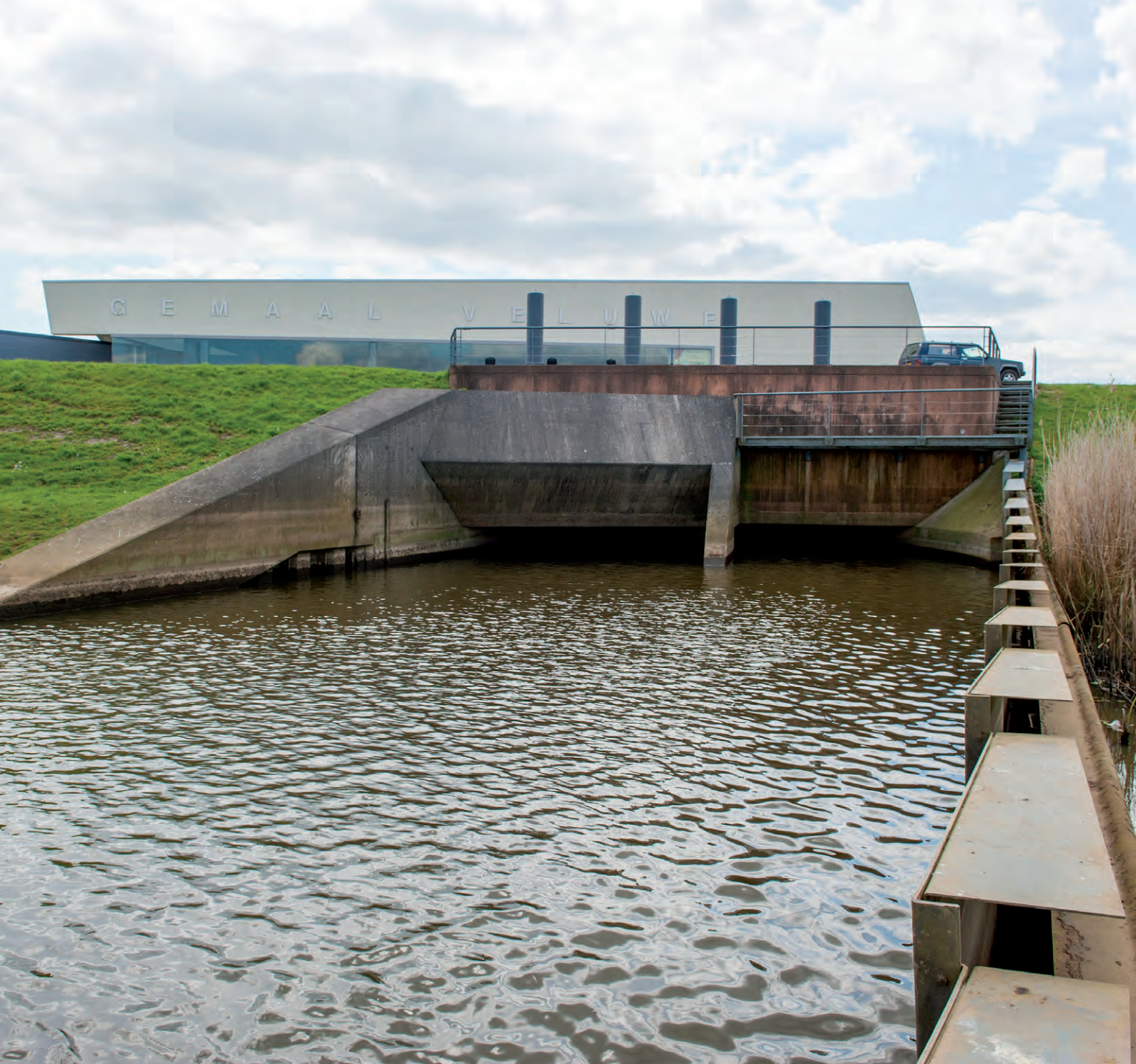
Gemaal Veluwe loost water via de Bottenstrank en de Veluwsche Wetering op de IJssel
