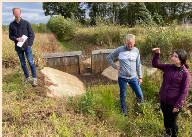
De Osink-Bemersbeek september 2020. Bovenstrooms van de knijpstuw is een 40 ha groot bergingsgebied op de grens met Duitsland. Natuurontwikkeling is de belangrijkste doelstelling, waarbij berging van neerslag en vertragen van de afvoer nevendoelestellingen zijn.
