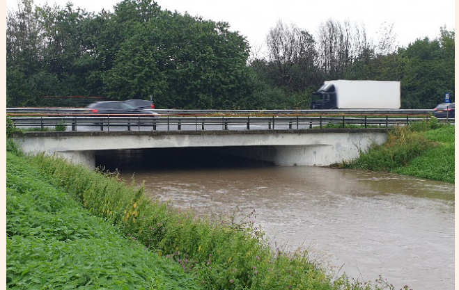
Geleenbeek stroomt onder de A2 en het Julianakanaal richting de Maas.
