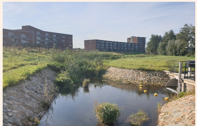
De 'oude' watergang die vanuit het landbouwgebied afvoert, komt pas benedenstrooms samen met het watersysteem van de nieuwe wijk.
