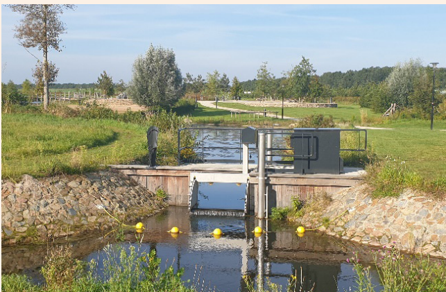
Stuw die waterpeil in de aangelegde bergingsvijver regelt.
