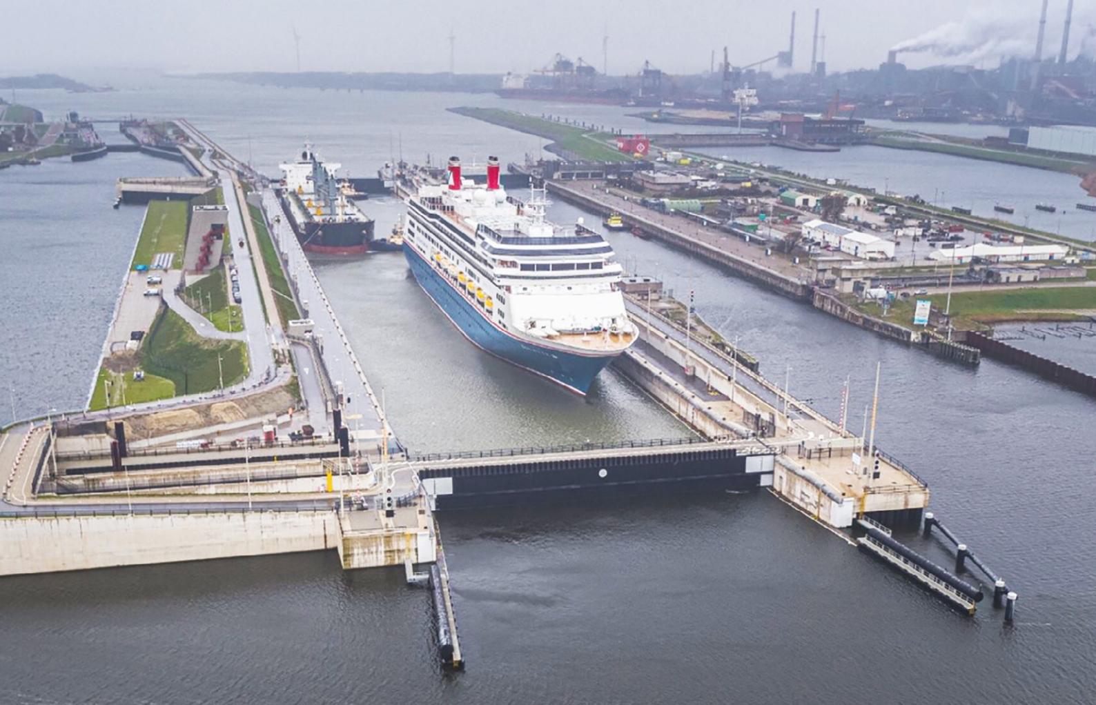
Figuur 3 Zeesluis IJmuiden
