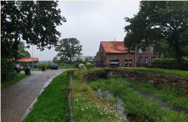
Oude watermolen bovenstrooms locatie brug 'Bij de Molen', Susteren. Oeverversterking aangebracht met Belgisch steen; koker onder de tuin van woonhuis.
