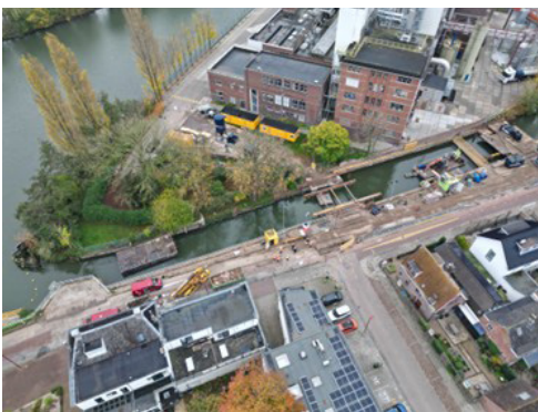
Figuur 7 De Doorslagsluis van bovenaf
