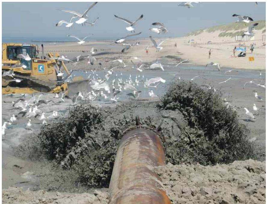
Het opspuiten van zand bij het strand van Vlissingen. Foto: Rijkswaterstaat, Jan van de Broeke
