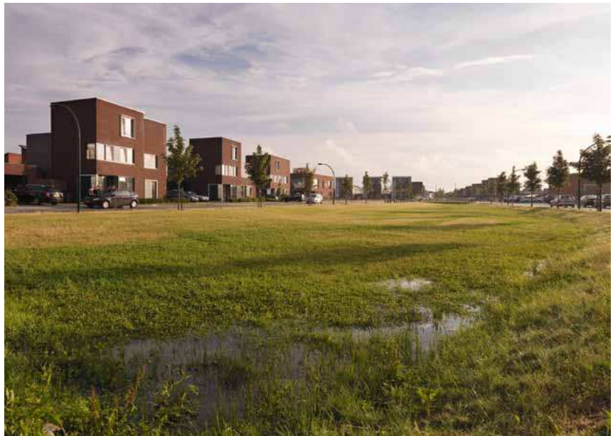
Wadi's in nieuwbouwwijk de Piekenhof in Berghem. Een wadi is een brede, ondiepe greppel, die bij zware regenval het hemelwater opvangt. Foto: Tineke Dijkstra
