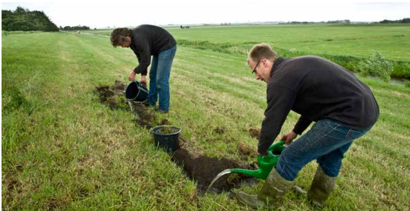
Medewerkers van een aannemer repareren met aarde en water scheuren in de veendijk langs de Zweth bij Den Hoom. De scheuren zijn ontstaan door langdurige droogte.
