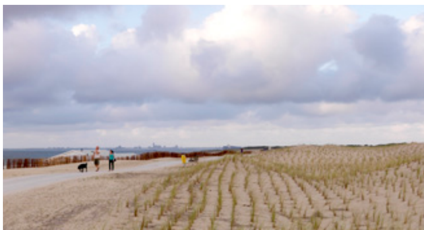
Een van de voorbeelden van het verbinden van water en ruimte is het project Waterdunen, onderdeel van de Zwakke Schakel langs de kust van Zeeuws-Vlaanderen. Hier is een nieuw en hoger duin opgespoten en ingeplant met helmgras, met een fiets- en wandelpad door het nieuwe duingebied en met daarachter een bijzonder natuurgebied met 350 hectare zilte natuur. Foto: Tineke Dijkstra
