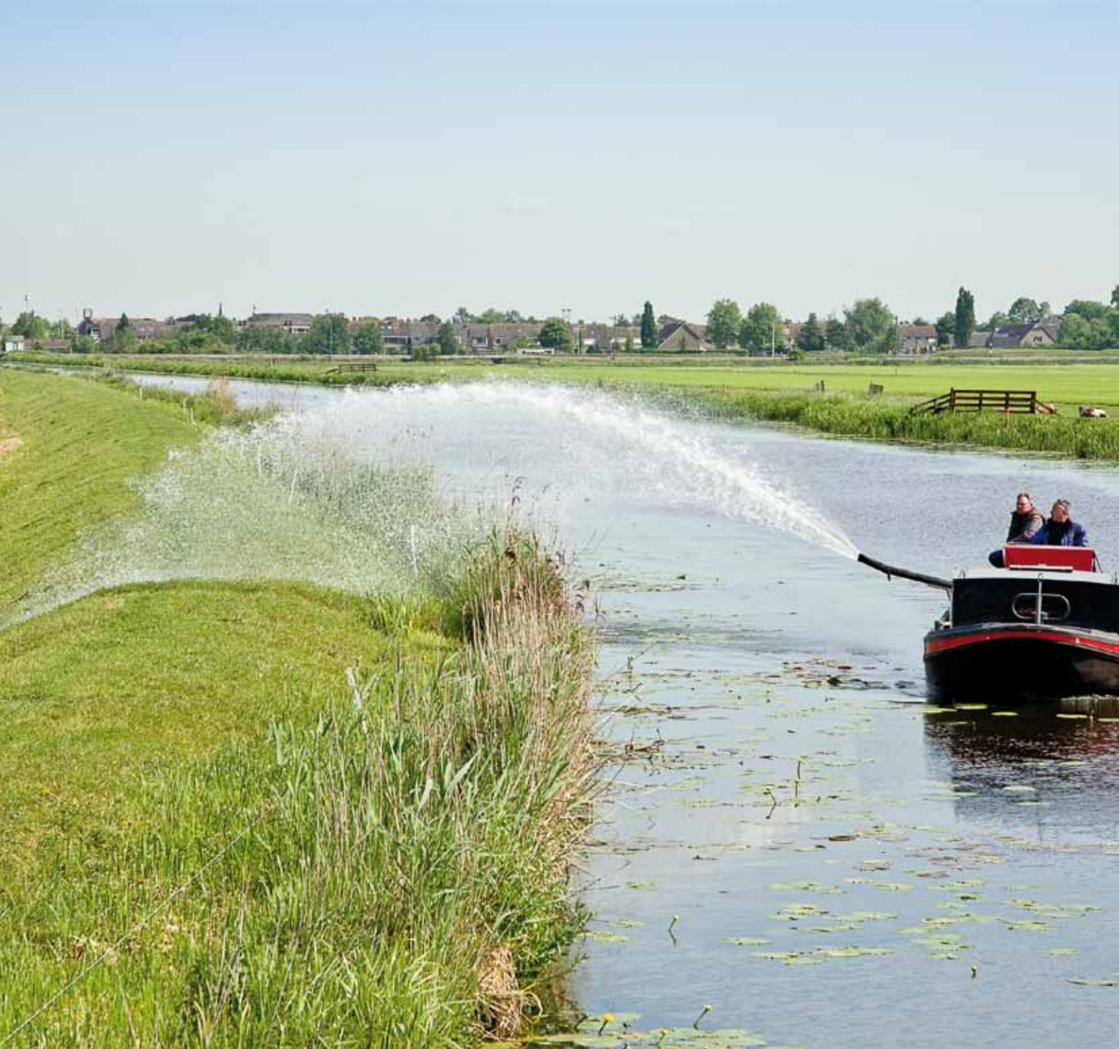
De dubbele Wiericke. Vanwege langdurige droogte besproeit Marikco van Rossum van het waterschap De Stichtse Rijnlanden vanaf een boot de langsliggende veendijken. Dit om scheurvorming en verzakking te voorkomen.
