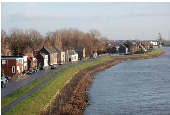
Figuur 38 Bebouwing dicht langs de dijk in de Alblasterwaard.
