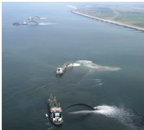
Figuur 31 Zandsuppletie (foto: Rijkswaterstaat)
