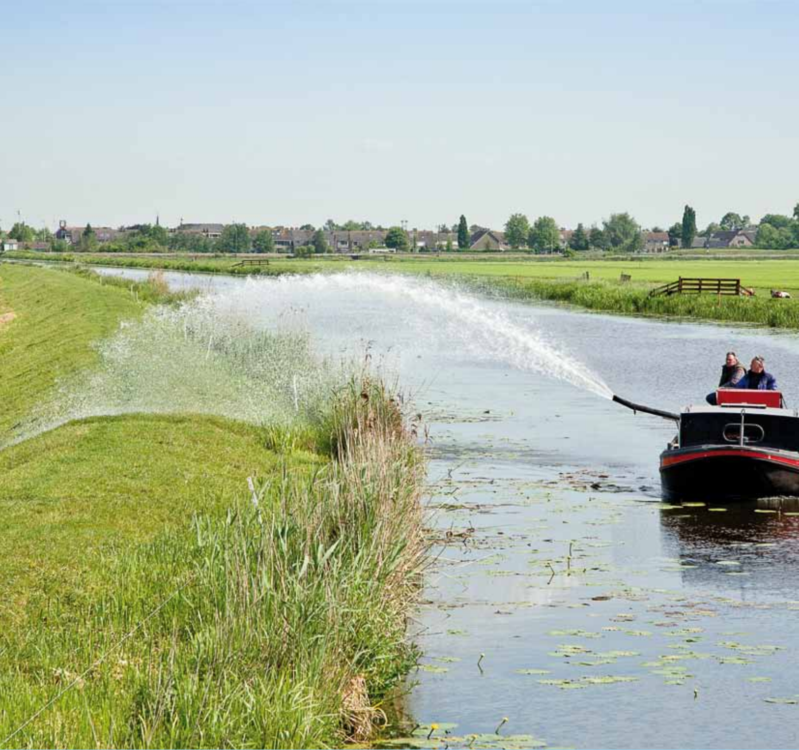
De dubbele Wiericke. Vanwege langdurige droogte besproeit Marikco van Rossum van het waterschap De Stichtse Rijnlanden vanaf een boot de langsliggende veendijken. Dit om scheurvorming en verzakking te voorkomen.
