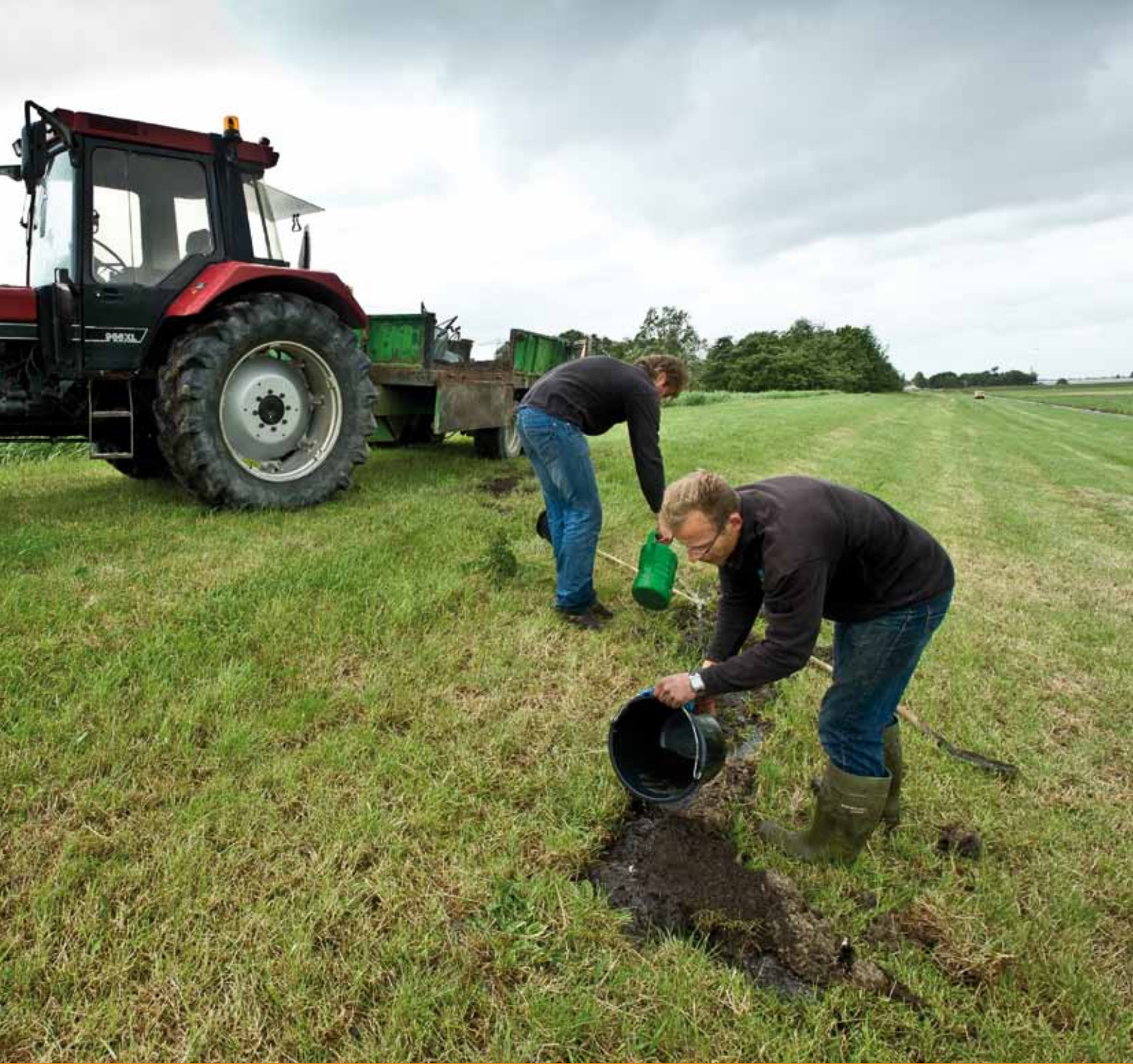
Medewerkers van een aannemer repareren met aarde en water scheuren in de veendijk langs de Zweth bij Den Hoorn. De scheuren zijn ontstaan door langdurige droogte.
