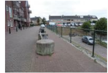
Lage oeverwal Eenzijdig bebouwd B14 Grave
