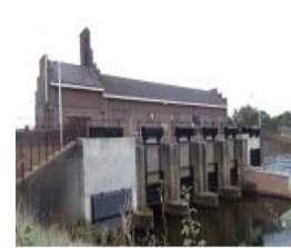
Markante plek > waterwerken B13 Gemaal v Sasse
