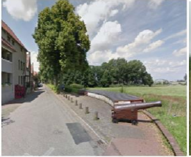
Markante plek > Vesting / Kanon op ronddeel B11 Ravenstein
