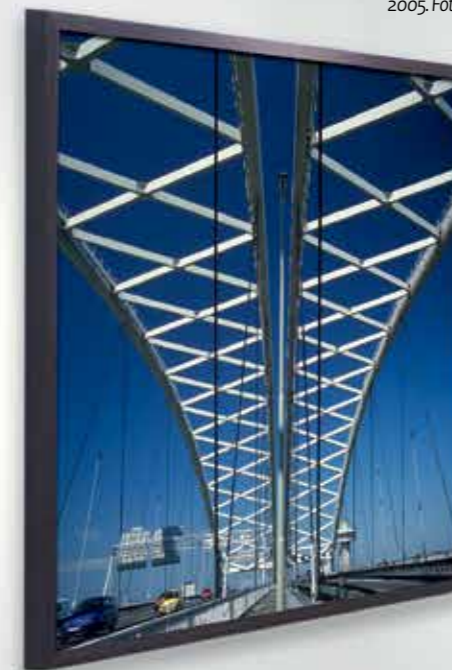
De twee boogbruggen van de Van Brienoordbrug in 2005. Foto: Dijkstra
