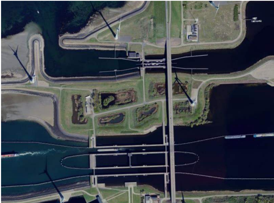
Afbeelding 2.9. Krammersluizencomplex (Bron: Cyclomedia)
