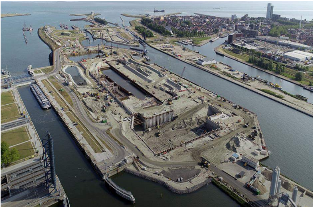
Afbeelding 2.19. Bouwkuip sluis IJmuiden. Bron: https://www.gww-bouw.nl/artikel/aanleg-bouwkuip-buitenhoofd-nieuwe-sluis-in-terneuzen-in-volle-gang/
