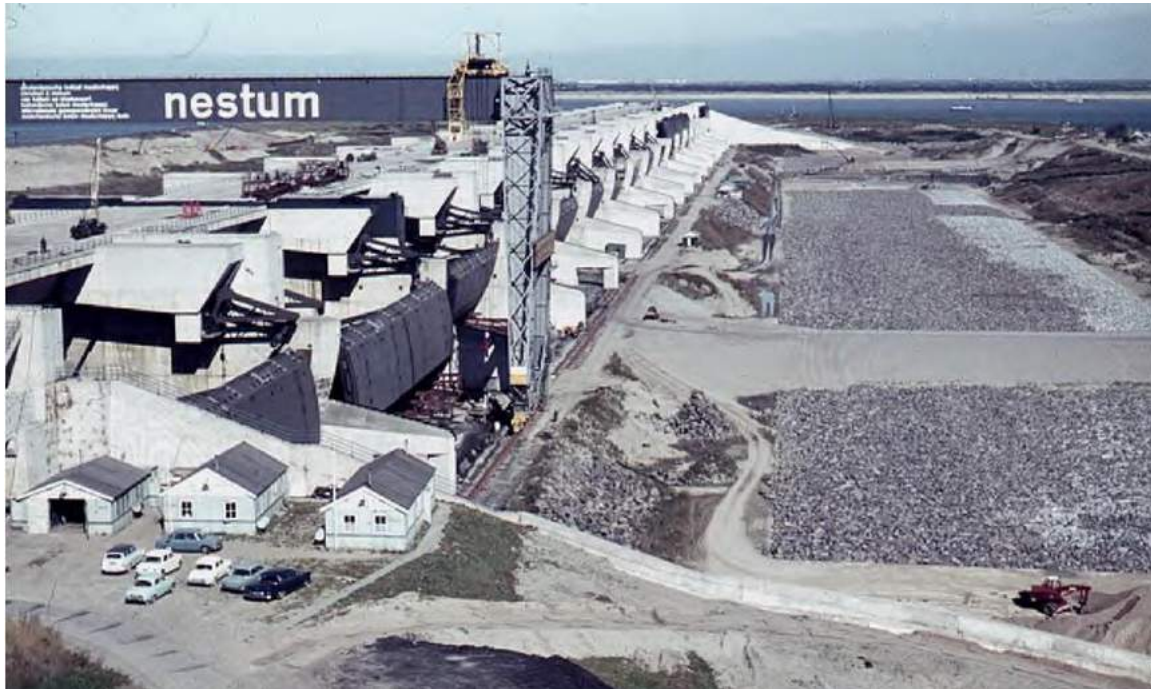
Afbeelding 2.17. Droge bouwkuip Haringvliet. Bron: Beeldbank Rijkswaterstaat, Astado
