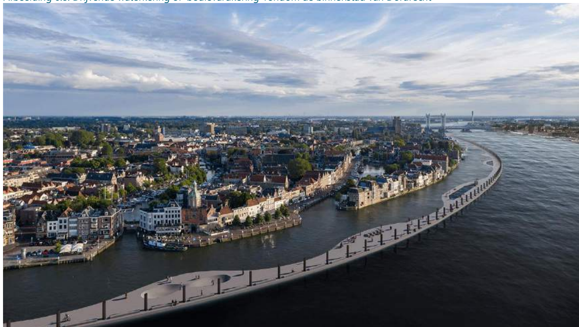
Afbeelding 6.8. Drijvende waterkering of 'boulevardkering' rondom de binnenstad van Dordrecht 1
