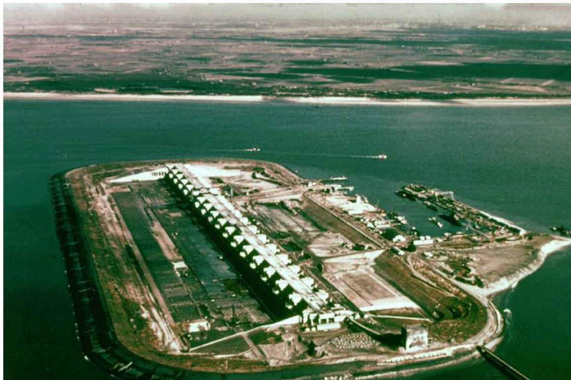
Afbeelding 2.18. Droge bouwkuip Haringvliet. Bron: Beeldbank Rijkswaterstaat, Astado
