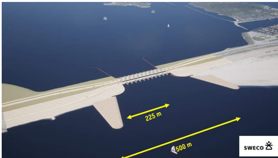
Afbeelding 3.8. Doorlaatmiddel in Brouwersdam voor herintroductie getij (bron: Sweco RWS, onderzijde is zeezijde)
