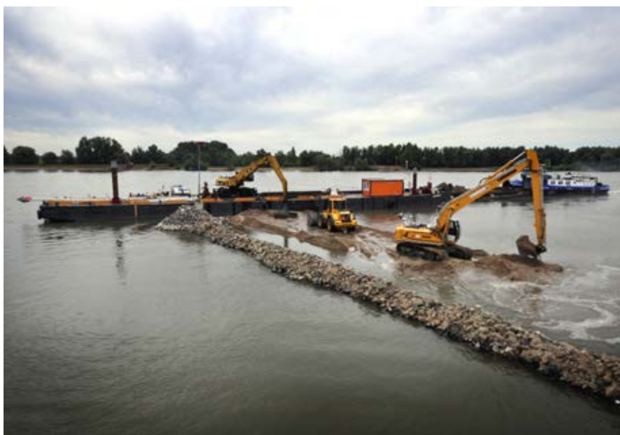
Werkzaamheden aan het verlagen van een krib in de Waal. Foto: Ton Borsboom
