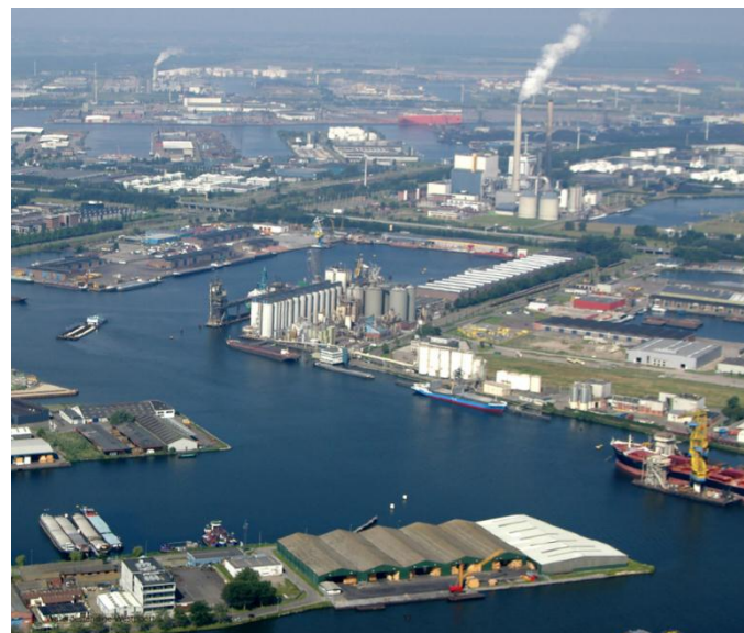
Foto 2. Westpoort, Amsterdam. Bron: Waterbestendig Westpoort.
