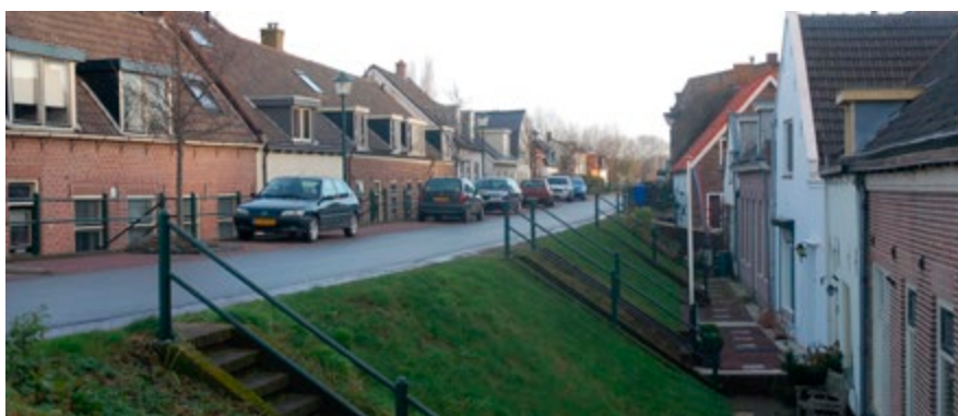
Dijkversterking in de Alblasserwaard-Vijfheerenlanden is een lastige opgave, want de dijken zijn er vaak bebouwd.
