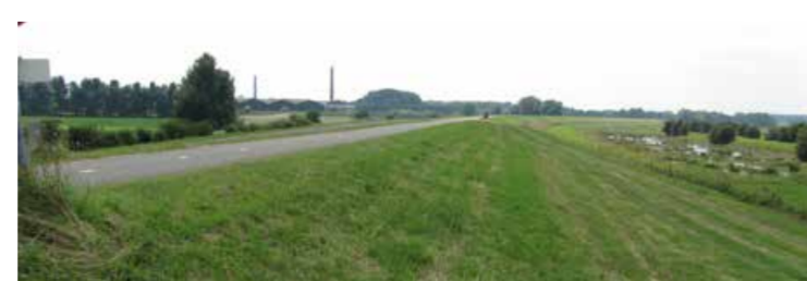
De 'Heerewaardense Afsluitdijk' keert aan twee zijden: Waal (rechts) en Maas (links).
