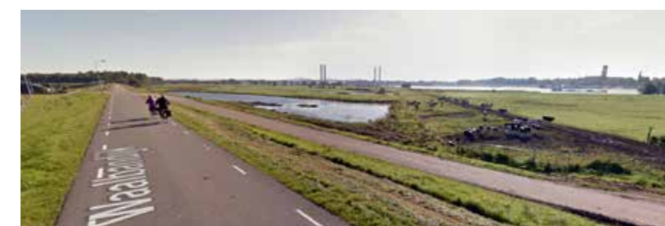
De dijk langs de Kerkewaard heeft een getrapt profiel met een fietspad op de kruin en de autoweg lager gelegen. Vanaf de dijk is er vrij uitzicht op Zaltbommel en de Martinus Nijhoffbrug en de graslanden en strangen (oud en nieuw) in de Kerkewaard zelf.
