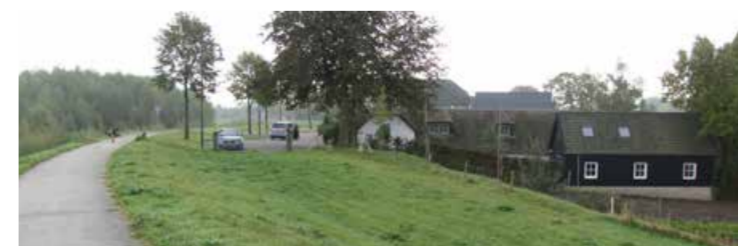
Dijk ten westen van Brakel met de tuimekade (het smalle hogere deel) door de eerdere buitendijks versterking.
