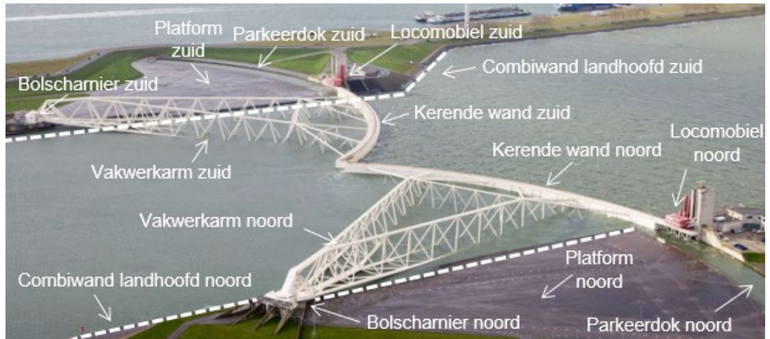
Figuur 1.2: De sectordeuren van de MLK in afgezonken toestand in de Nieuwe Waterweg (Deltares, 2022a).
