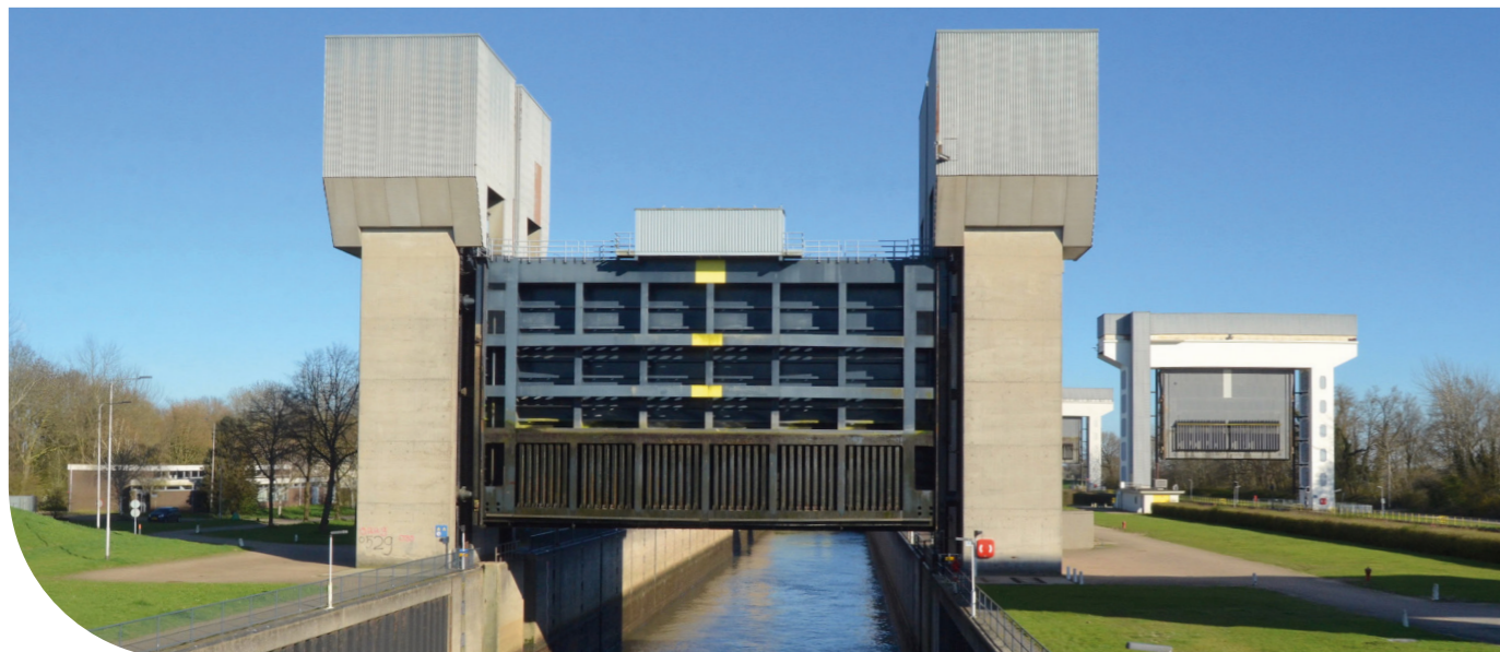
Figuur 26. De Irenesluizen hebben vanaf 2 meter zeespiegelstijging onvoldoende capaciteit om genoeg rivierwater door te laten voor verziltingsbestrijding.
