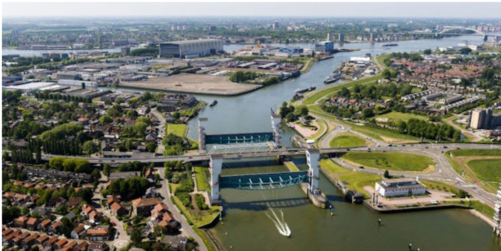
Figuur 100: Luchtfoto van de Hollandsche IJsselkering in de richting van de Nieuwe Maas (bron: https://www.rijkswaterstaat.nl/water/waterbeheer/bescherming-tegen-het-water/waterkeringen/deltawerken/hollandsche-ijsselkering ).
