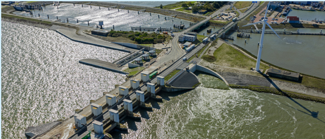
Spuisluizen Den Oever. Foto: Rijkswaterstaat/Droneview
