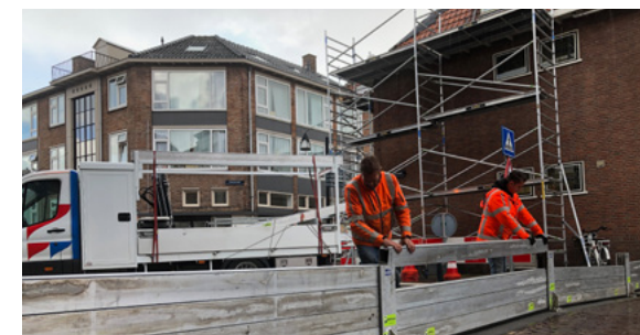
Foto: Jaarlijkse test plaatsen vloedschotten in de Voorstraat, Dordrecht
