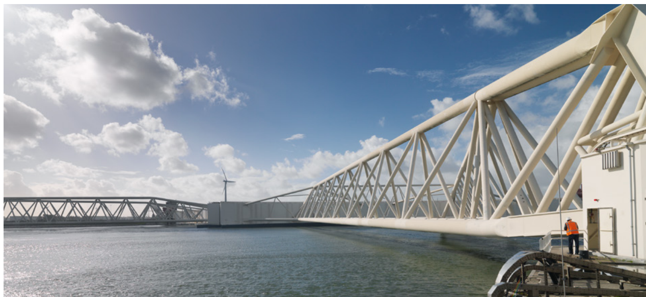
Foto: Gesloten Maeslantkering
