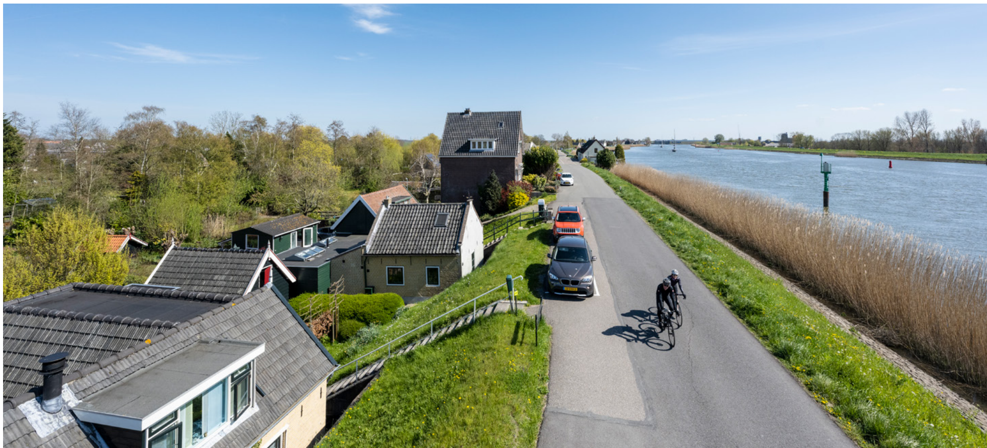
Foto: Lintbebouwing langs/in de dijken langs de Hollandsche IJssel
