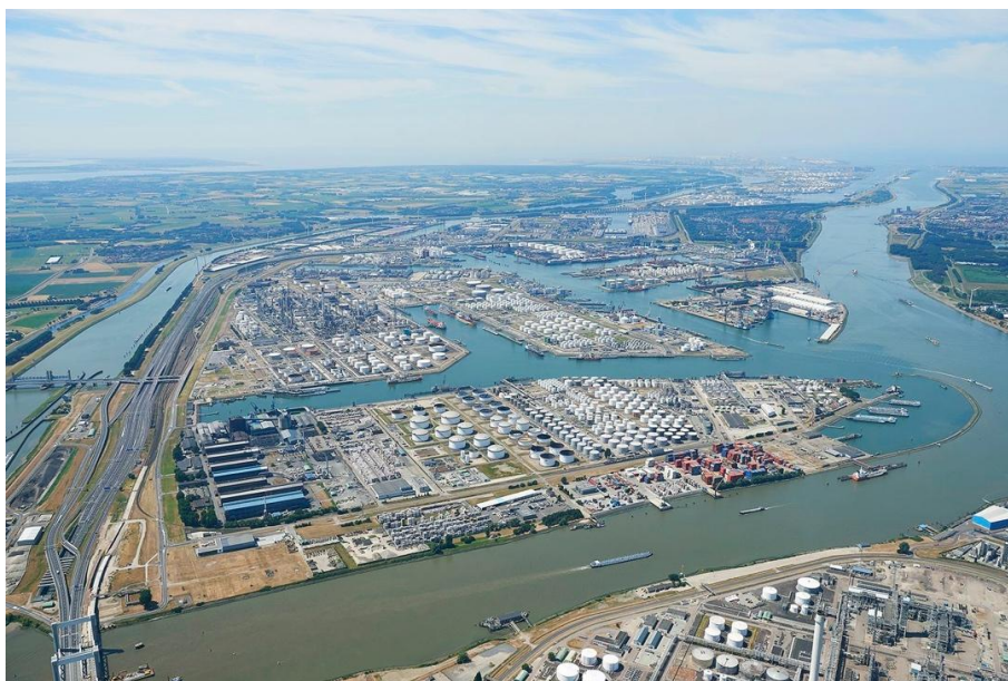
Foto 2: Botlek Vondelingenplaat (Havenbedrijf Rotterdam)
