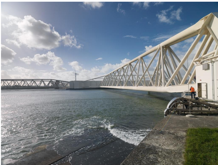
Foto 9: Sluiting Maeslantkering (Tineke Dijkstra)
